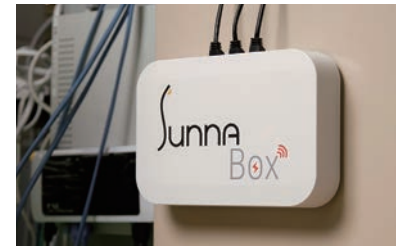
取付けをする
